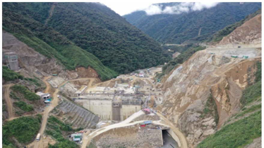
Vista general de la construcción de la presa en Sehuencas.
