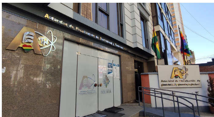
AETN aprueba tarifas base para siete Distribuidoras de electricidad
