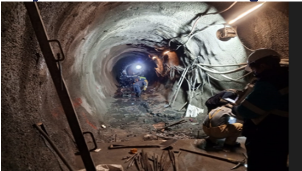
Avance de obras Túnel 1.
